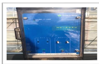
ブルーベリー園の自動灌水とハウス3棟の環境制御が可能に
