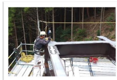
現場での測量の様子
